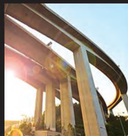
橋工事、大橋、鉄道、 構造物施行
